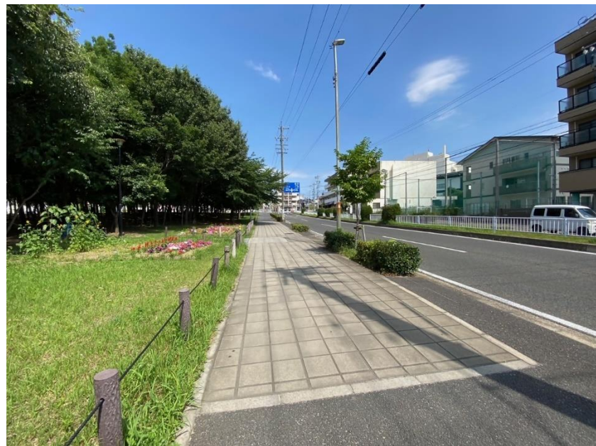
保水性ブロック舗装
